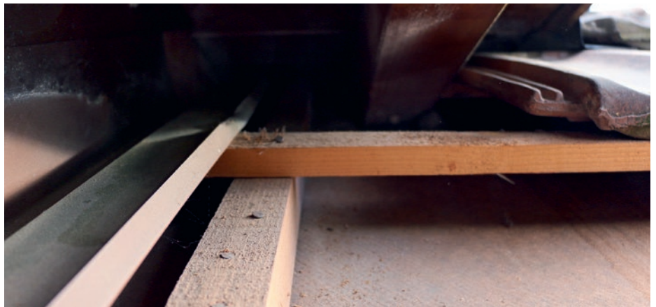
Professionelle Demontage der Dachziegel, um Schäden zu eruieren.
