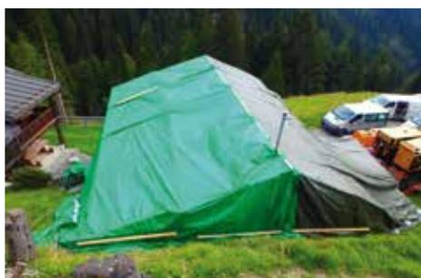
Abb. 1: Das Maiensäss ist eine zweigeschossige Holzkonstruktion, a) vor und b) nach der Einhausung.
