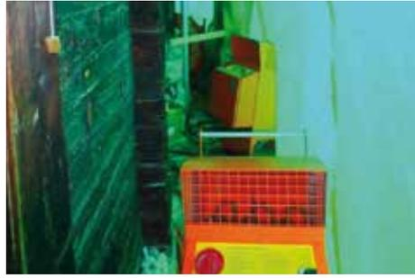
Abb. 3: a) Innenraum im Maiensäss und b) Zwischenraum Außenwand und Plane mit zwei WEO 18 kW.
