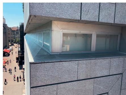
Von blosserem Auge kaum sichtbar: die Taubenabwehr von Mauerwerken, hier die Vernetzung eines Geschäftshauses. Das Netzmaterial ist transparent, UV-lichtgeschützt und wetterfest.
